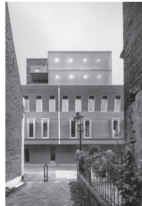
De toegankelijke voorzijde van het gebouw.
