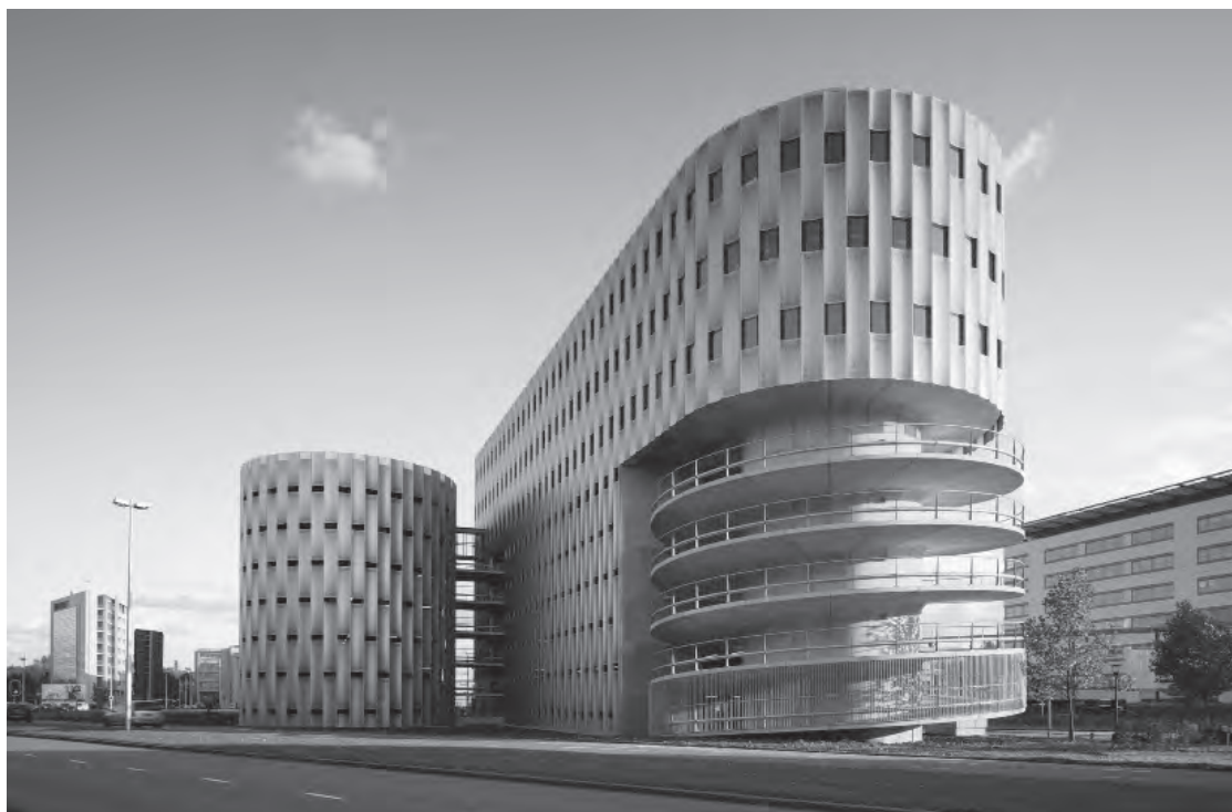
Parkeergarage de Cope met kantoren erboven van JHK.
