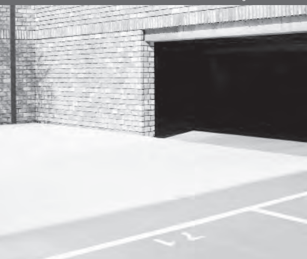
Woningbouw Langerak veld 6 en 11 Biq architecten
