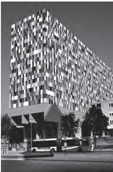
Het opvallende gevelbeeld van Smarties aan de Heidelberglaan.
