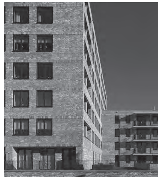
Zorgvuldige detaillering van het woonblok in Langerak.
