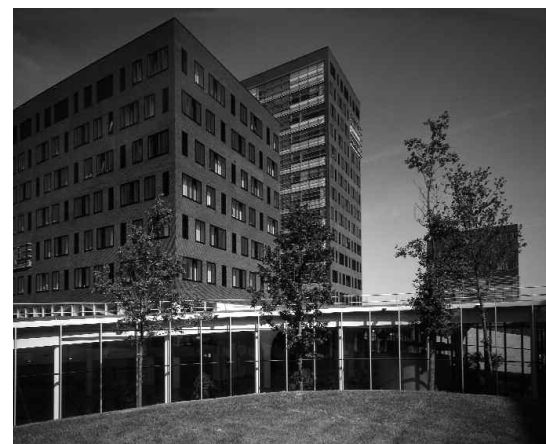
Kantoorgebouw Cap Gemini, Papendorp
