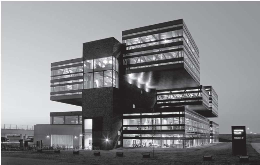
Met een evenwichtsconstructie 'hangen' glazen boxen met grote overstekken aan de met bakstenen beklede betonnen kern
