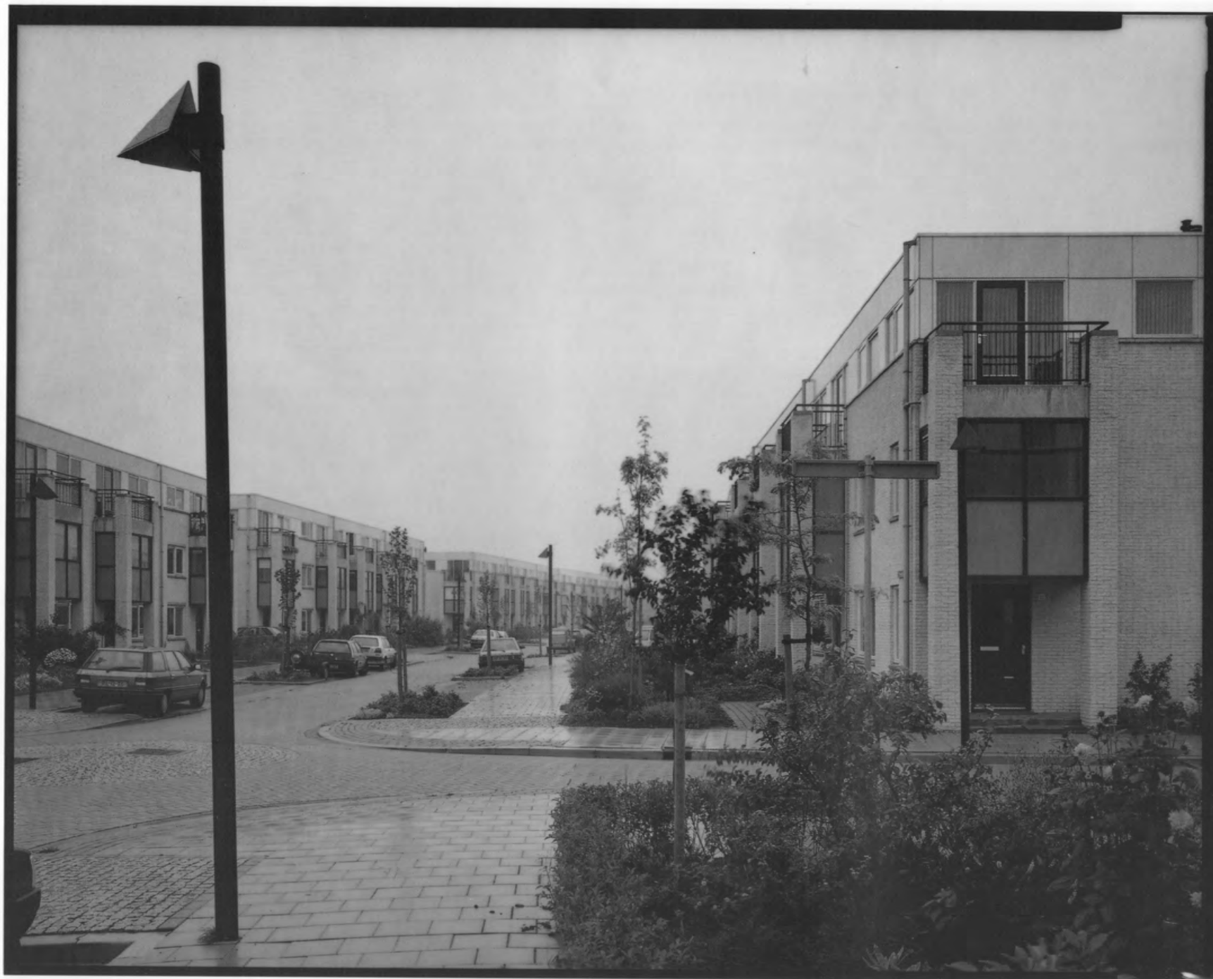
16 Eengezinswoningen, Tulagstraat (Voordorp)
