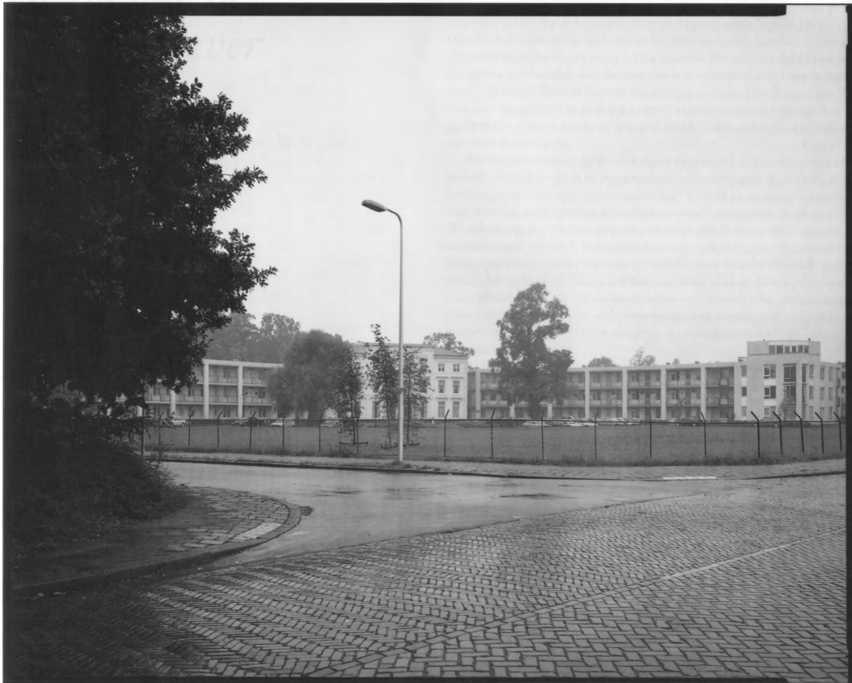
20 Seniorenhuisvesting 'Park Welgelegen', Leidseweg 140 (Oog in Al)
